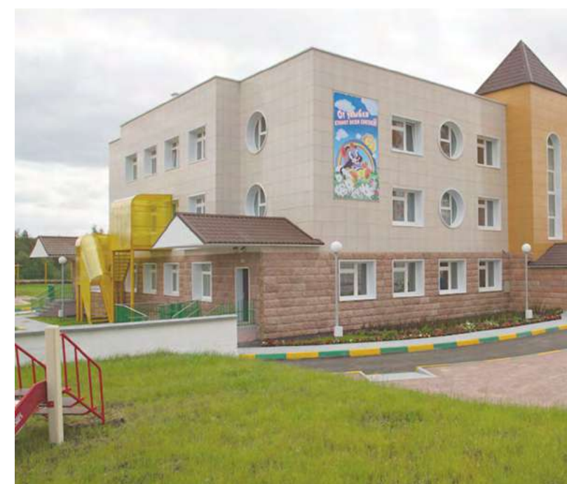
Строительство детского сада «Улыбка»
