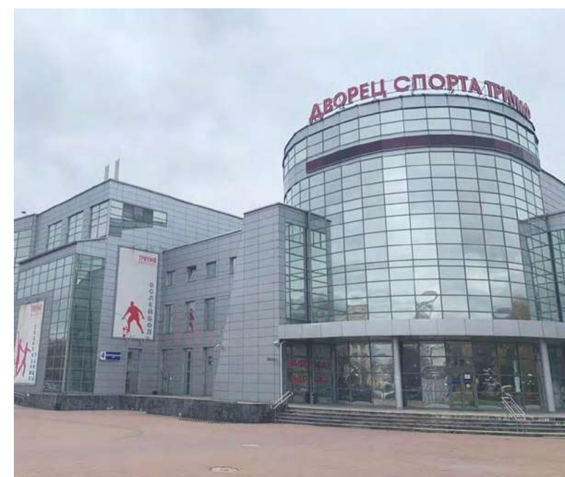
Поддержка строительства дворца спорта «Триумф»
