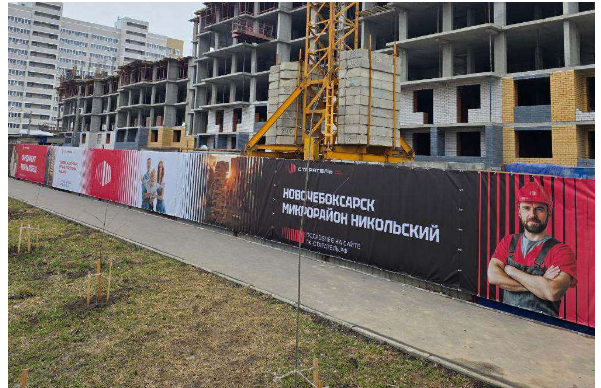
НОВЫЙ СТРОИТЕЛЬНЫЙ ЗАБОР
