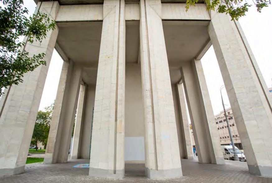
В силу того, что архитекторы ранее занимались строительством атомных реакторов, некоторые их особенности можно обнаружить и у «дома-корабля». Так, несущие стены расположены под углами  $87^\circ$  и  $93^\circ$  вместо обычных  $90^\circ$ , что повышает его сейсмическую устойчивость, препятствуя складыванию, а между парами подъездов устроены пролёты <sup>①</sup> с высокими колоннами, чтобы не обходить весь дом по периметру.
