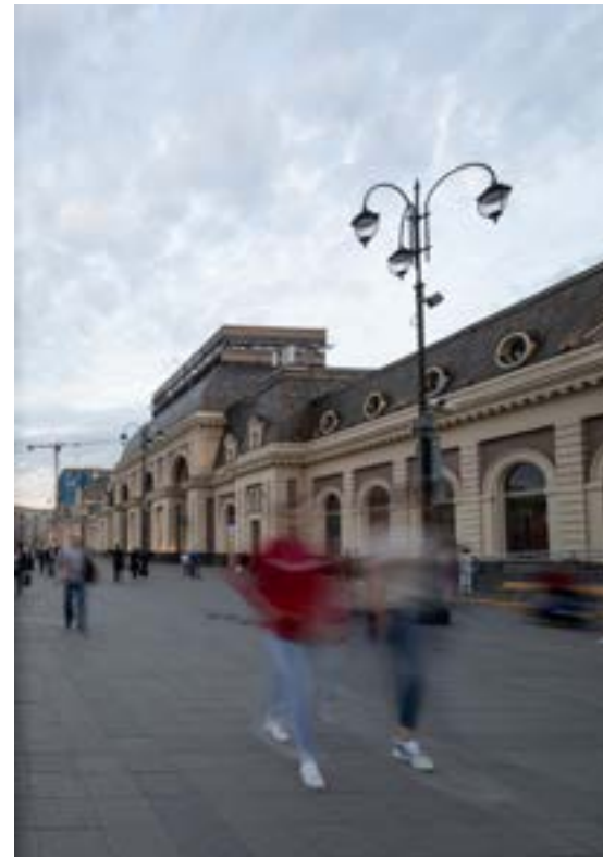
Вокзал возведен по канонам конца 19 века: симметрия, высокие окна, широкий удобный подъезд
