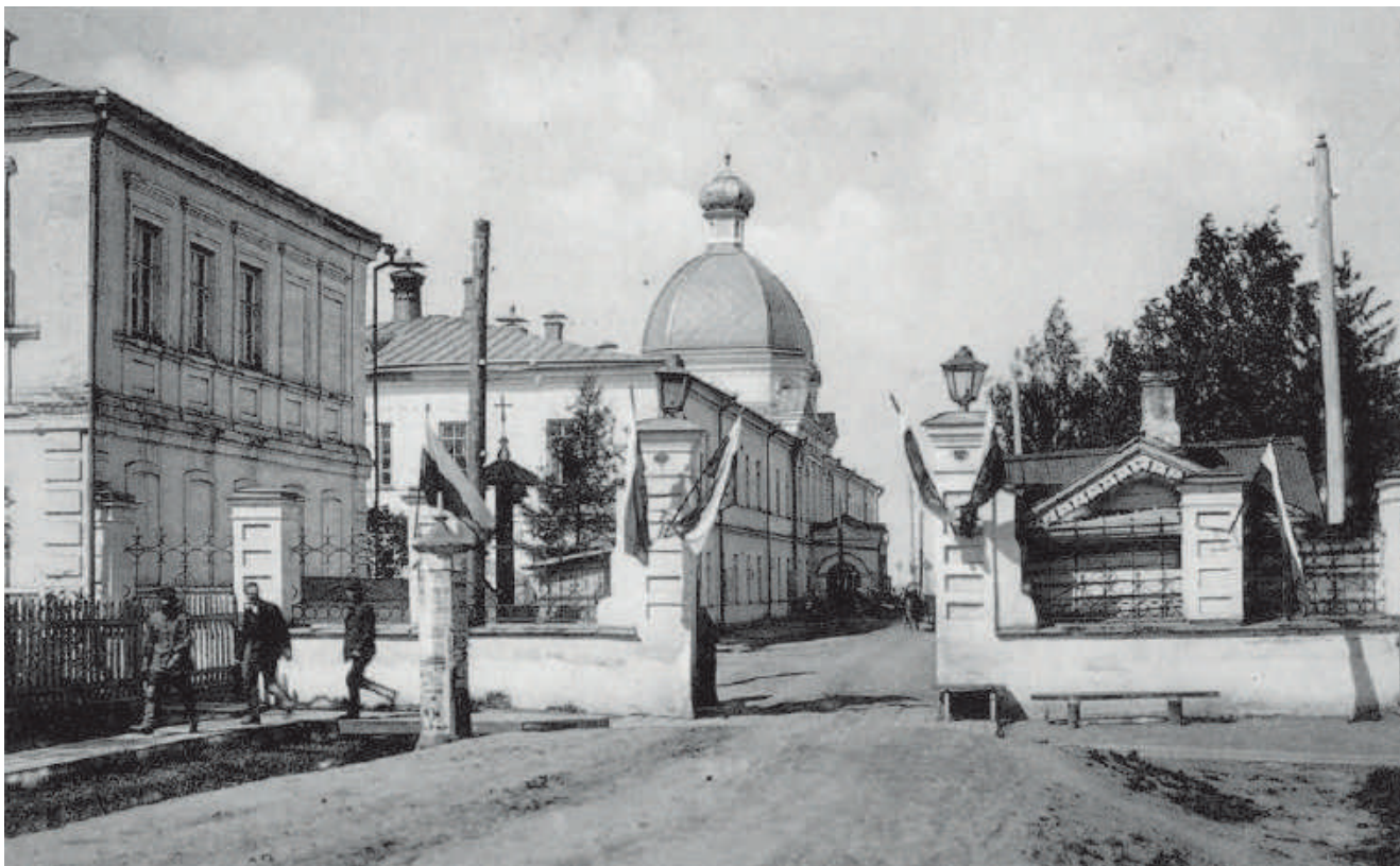
Вид на губернную земскую больницу и домовую (была встроена в главный больничный корпус) Скорбящую Богородицкую церковь. Г. Вятка. 1900–1917 гг.
