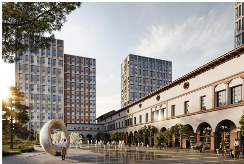
ЗДАНИЕ ИЗОФАБРИКИ АРХИТЕКТОРА ГЕОРГИЯ ГОЛЬЦА ( SOUL )
