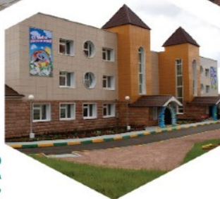
СТРОИТЕЛЬСТВО ДЕТСКОГО САДА «УЛЫБКА»
