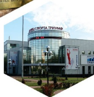
ПОДДЕРЖКА СТРОИТЕЛЬСТВА ДВОРЦА СПОРТА «ТРИУМФ»
