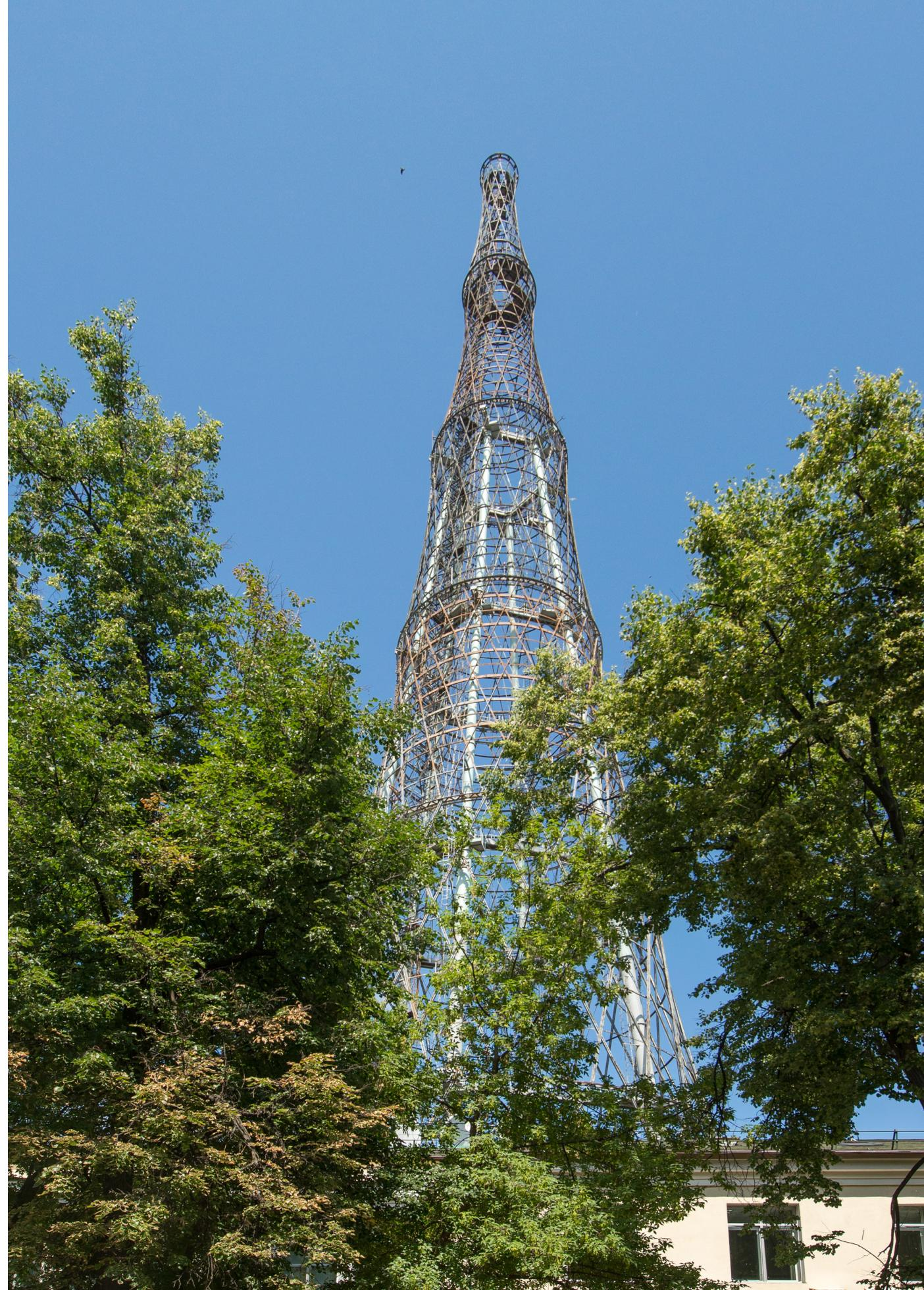
Расположена в Москве на улице Шухова рядом с телецентром на Шаболовке. Построена в 1920–1922 годах по проекту архитектора и изобретателя **ВЛАДИМИРА ШУХОВА**. В конструкции башни использованы изобретённые и запатентованные Шуховым гиперболоидные конструкции <sup>①</sup> и металлические сетчатые оболочки. Башня составлена из шести секций, расположенных одна над другой. Каждая секция представляет собой самостоятельный гиперболоид, опирающийся на более крупный нижестоящий.
