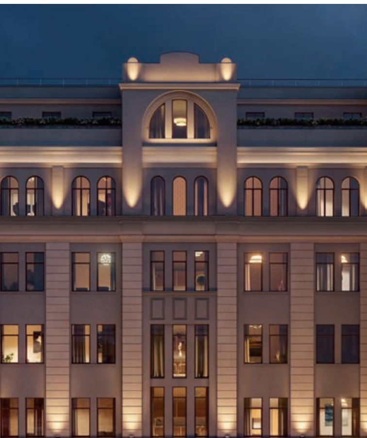
Архитектурная подсветка фасада
