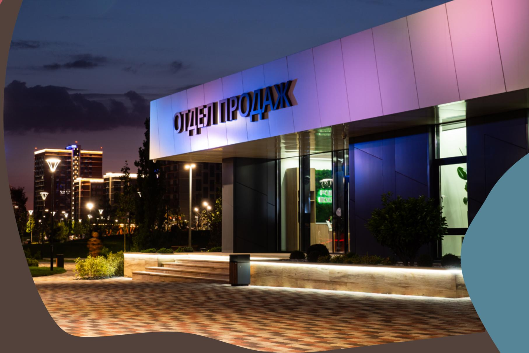
Здание представляет собой быстровозводимую конструкцию на металлическом каркасе. Отделка фасада – композитные и перфорированные панели двух цветов.
